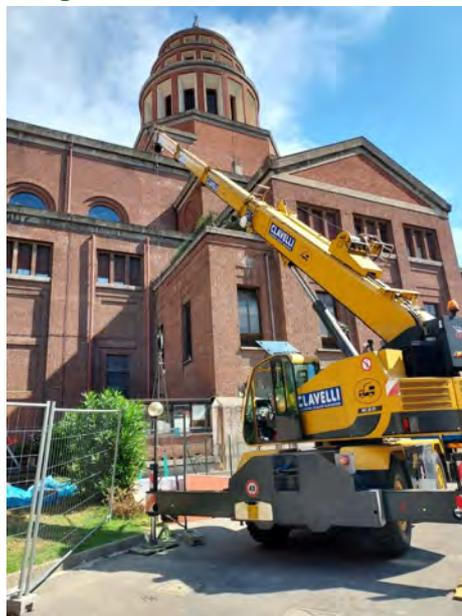
STIAMO CAMBIANDO LA CALDAIA PER IL RISCALDAMENTO DELLA BASILICA. DOPO STUDI E RICERCHE ALLA FINE ABBIAMO DECISO CON IL CONSIGLIO AFFARI ECONOMICI DI PASSARE ANCHE IN BASILICA AL TELERISCALDAMENTO: QUI VIENE CALATO IL NUOVO SCAMBIATORE DI CALORE E L'U.T.A.
