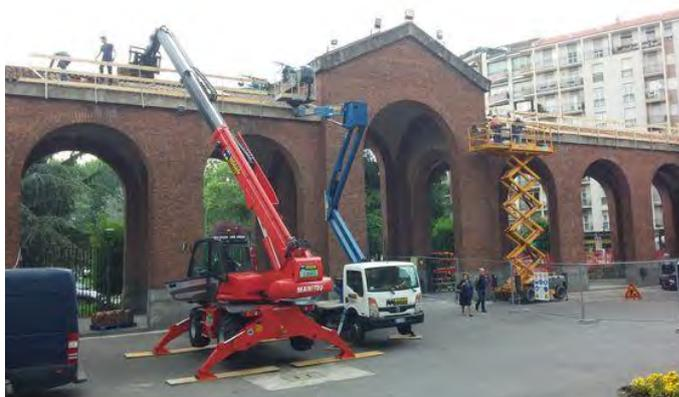
Proseguono i lavori di restauro statico e conservativo del quadriportico. L'intervento è significativo (nuova impermeabilizzazione del tetto, chiusura delle fessurazioni, messa in opera di tiranti, pluviali, nuova tinteggiatura e illuminazione ...) e il costo, come potete immaginare, ingente.
