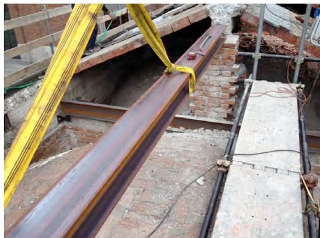
**IL TETTO DEL PORTICATO DI SINISTRA ANDRÀ COMPLETAMENTE RIFATTO (SÌ, AVETE LETTO BENE!), SOSTITUENDO IL VECCHIO CEMENTO ARMATO CON PUTRELLE E ORDITURA IN FERRO**
