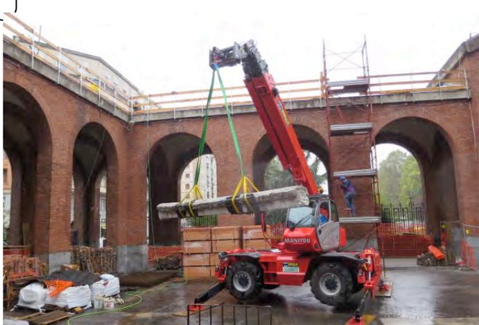
**TUTTO IL TRAVE PORTANTE DEL PORTICATO DI SINISTRA, VUOI PER L'ASSETTAMENTO, VUOI PER LA SCARSITÀ DI FERRO UTILIZZATO IN TEMPO DI GUERRA PER LA COSTRUZIONE, COL TEMPO SI E' SPEZZATO IN TRE PUNTI**
